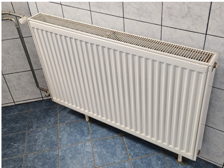
Slika 14: Radiatorsko ogrevanje - nameščeni termostatski ventili
